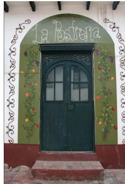
FIGURA. 11. Intervención de fachada Tibasosa. Boyacá
