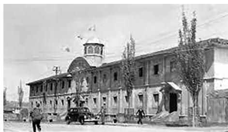
Foto de la primera edificación de la Escuela Normal de Manizales (Archivo Institucional)
