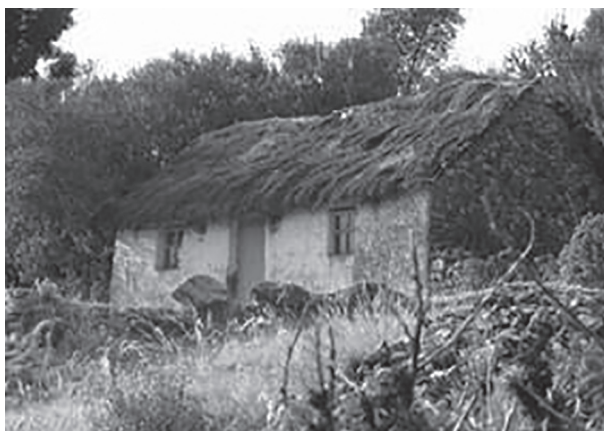
Imagen 1. Escuela de Utawilaya de Manuel Zúñiga Camacho construido en 1902, de material de adobe e Ichu 29 .
