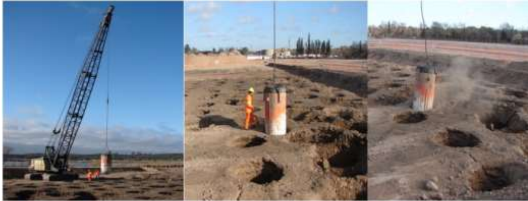
Fig. 3. Proceso de compactación dinámica en la planta de Bajo Grande, Córdoba.
