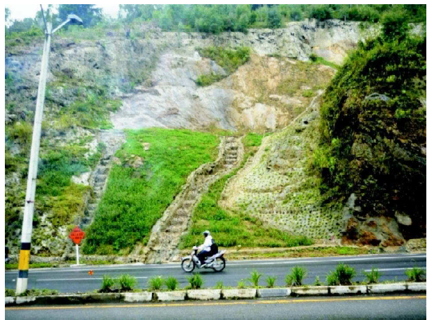
Foto 2. Terreno tratado con pasta fértil, totalmente revegetalizado; km 2 + 300 Vía Doble Calzada Medellín-Las Palmas.
