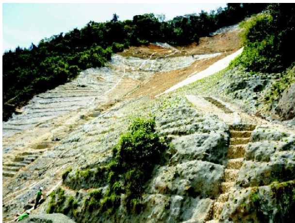
Foto 1. Mortero ecológico aplicado directamente sobre el talud; km 3 + 200 Vía Doble Calzada Medellín-Las Palmas.
