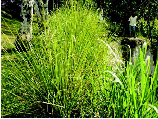
Foto 5. Detalle del crecimiento de Vetiver sobre el mortero ecológico. Finca La Victoria, municipio de Amagá -Antioquia- Fuente: el autor, abril de 2010
