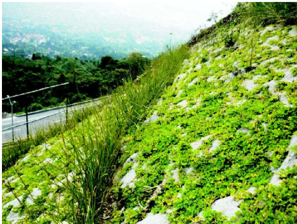
Foto 6. Detalle del crecimiento de vegetación nativa y leguminosa entre surcos de Vetiver; km 3 + 200 Vía Doble Calzada Medellín-Las Palmas Fuente: Gómez, Luz Stella, Marzo de 2010
