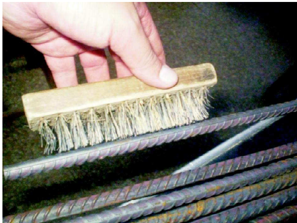
Figura 8. Limpieza de las barras
