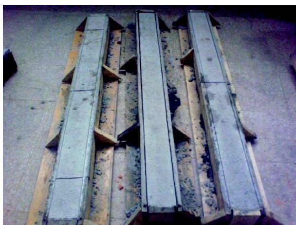
Fig. 18. Fraguado de vigas de concreto
