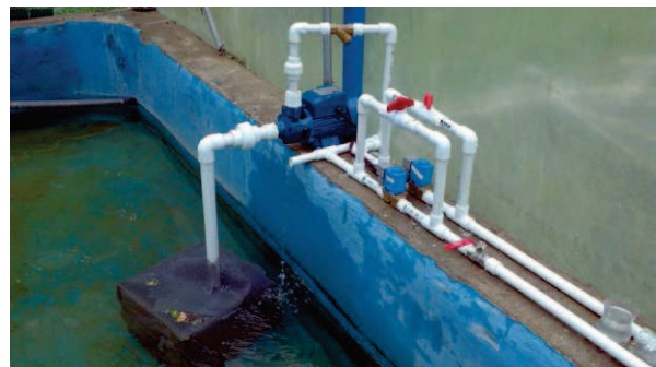
FIG. 17. Instalación de la motobomba y las electroválvulas
