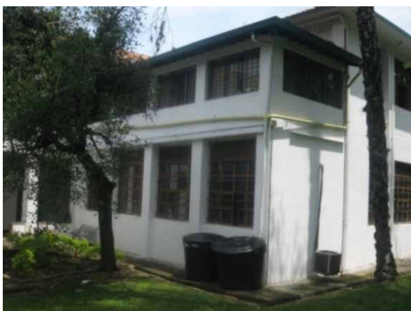
FIG. 2. Tuberías y tanques de almacenamiento del agua lluvia. Fuente: Medina, C.
