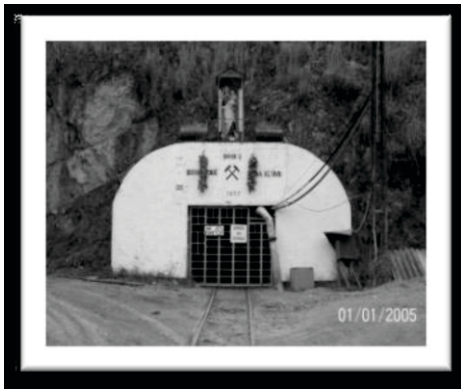
Figura 1. Vista de la entrada a un túnel de la mina El Uvo Acerías Paz del Rio Boyacá Colombia.
