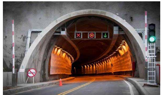
Figura 2. Túnel de Daza (Variante Oriental de Pasto, Colombia).
