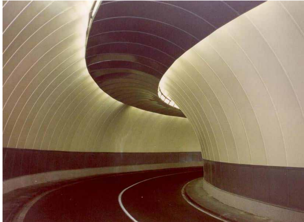
Figura 20. Vista del túnel con los paneles instalados. Fuente: Alliance (2010)
