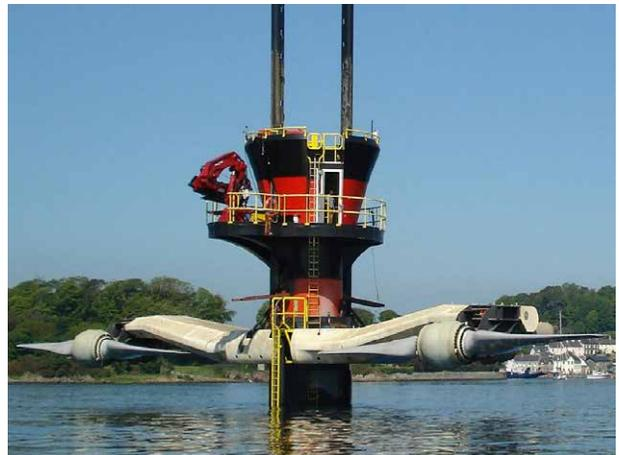
**Figura 3.** Sistema de generación de energía mareomotriz compuesto por dos turbinas con dos cuchillas con eje horizontal. Proyecto SeaGen en Strangford Lough, Irlanda (potencia de turbina: 1,2 MW).
