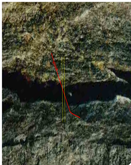
Figura 6. Detalle de la falla inversa ubicada en la parte derecha de la fotografía expuesta en la Figura 1.
