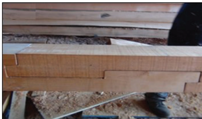
Figura 4. Empalme de llave con traba (fotografía del proceso de restauración tomada por uno de los participantes).
