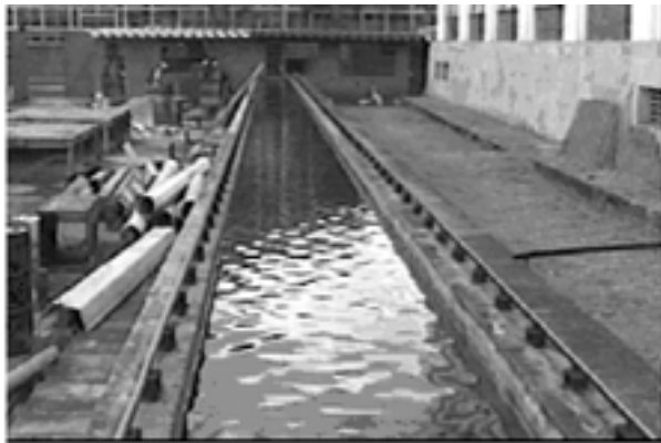
Figura 6. Canal empleado para el patronamiento del medidor de caudal.
