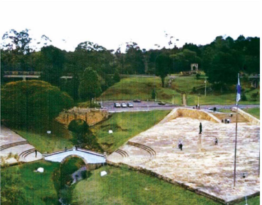
Imagen 16. Puente Histórico con barandas encaladas (1940); Plaza de Armas (1969) y antigua Carretera del Norte, convertida en estacionamiento vehicular de visitantes. Fotografía inédita del ingeniero Daniel Crisanchó, 2015.
