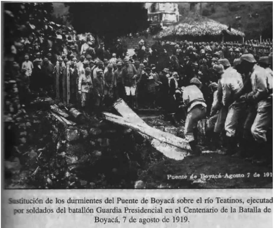
Imagen 2. Sustitución de los durmientes del Puente Histórico de Boyacá sobre el río Teatinos, ejecutado por soldados del batallón Guardia Presidencial en el centenario de la Batalla de Boyacá. Imagen reproducida en el BHA.
