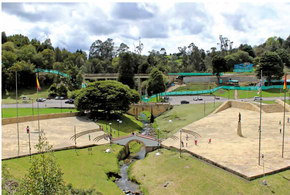
Imagen 3. Panorámica que muestra los tres puentes construidos en diferentes épocas del siglo xx, dentro del Parque Histórico asociado con la Batalla del Puente de Boyacá, en el proceso de “modernización” del Campo Histórico y de la vía de comunicación Bogotá – Tunja. Al fondo se aprecia la invasión de la intervención actual y su cercanía al puente histórico de Boyacá. Fotografía: Hans Christian Wiesner Moreno.
