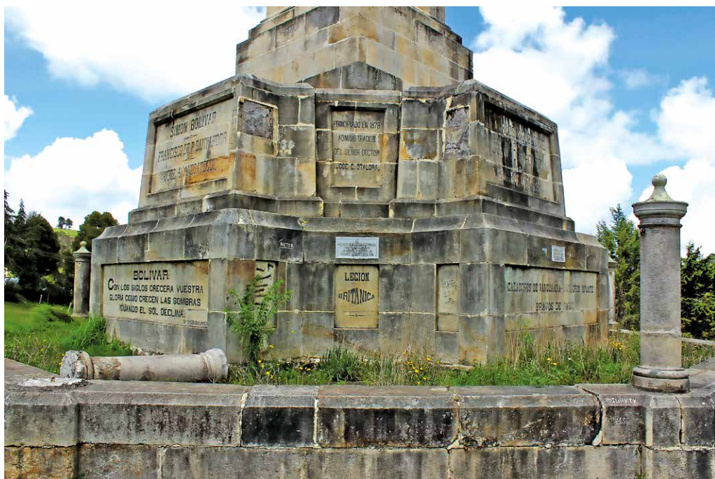
Imagen 10. Monumento el Obelisco. Estado de ruina y deterioro por graffitis, pérdida de placas de bronce conmemorativas, ruptura y caída de columnas que lo rodean en la base, pérdida de la cadena de bronce que enlazaba las columnas del contorno del obelisco, crecimiento de vegetación y pasto en el interior de la base. Fotografía: Hans Christian Wiesner Moreno.
