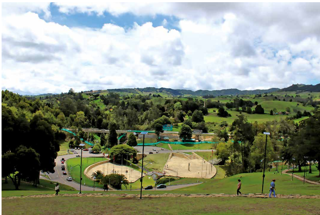
Imagen 2. Panorámica que muestra al Puente de Boyacá, la Plaza de Armas construida en 1969 y parte del área de intervención de la doble calzada adosada a la vía actual, señalizada con la lona verde. Al fondo, al otro lado de la vía el Arco del Triunfo y el Obelisco. A la derecha se aprecia el nuevo muro de contención que se levantó y a la izquierda el puente sobre el río Teatinos, al que se adosará un nuevo puente de 71 metros de longitud. Fotografía: Hans Christian Wiesner Moreno.
