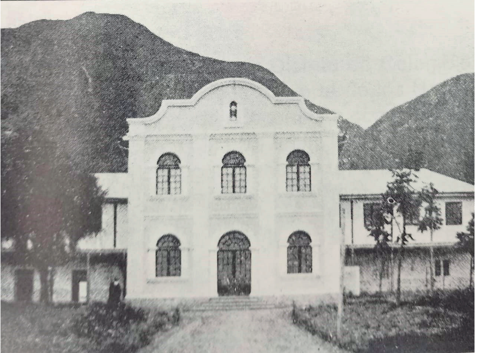
Imagen 3. Frontis del Noviciado en Chapinero, 1896. Fuente: Fotografía tomada del Archivo del Distrito Lasallista de Bogotá.
