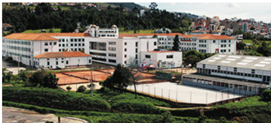
Figura 1. Edificio Central de la Uptc, diseñado con la arquitectura del panóptico, consta de dos alas y en la mitad de las dos una cúpula que sobresale, sitio donde se encontraba la dirección y desde donde se podía observar a los estudiantes. Fuente: http://www.uptc.edu.co
