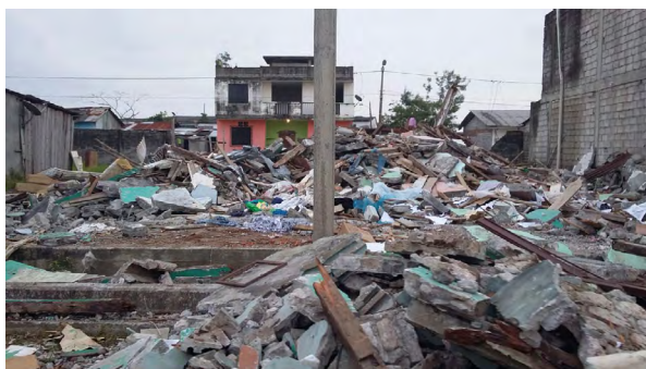
Figura 1. Escombros de parte de la casa de Nachita en abril de 2016
