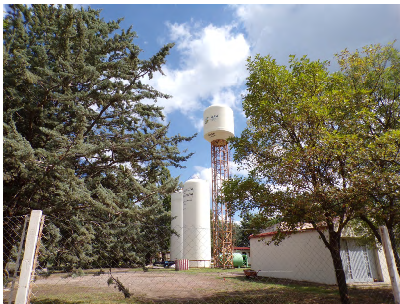
Figura 4. Tanque de agua en la localidad de Santa Isabel (La Pampa) que recibe el agua proveniente de Punta del Agua (Mendoza)
