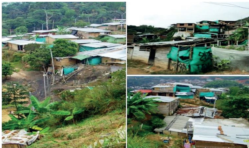
Figura 5. Conglomerado de viviendas en el asentamiento de estudio
