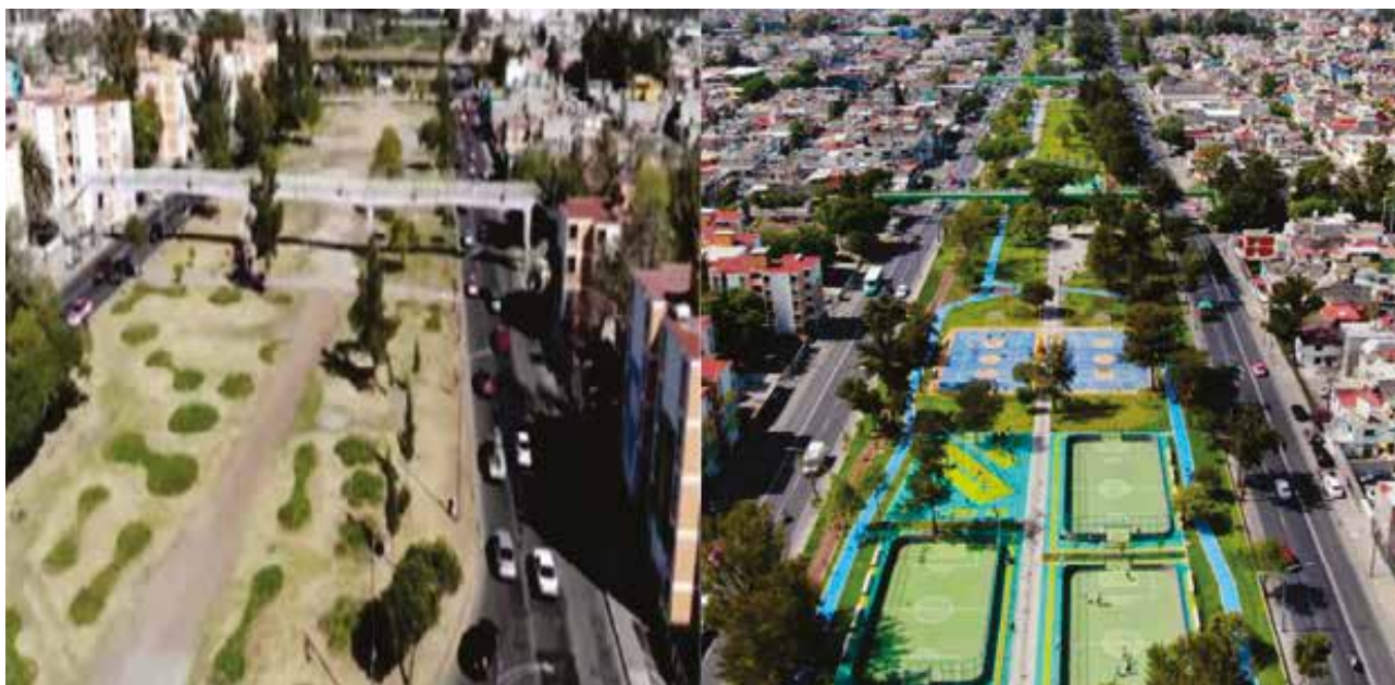
FIGURA 2. Parque Periférico Oriente antes y después de su remodelación
