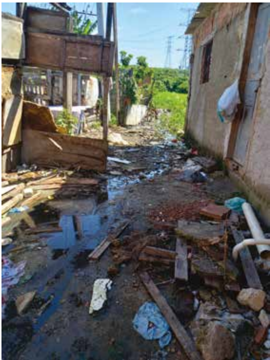
FIGURA 4. Esgoto “à céu aberto” em viela da comunidade da favelinha no Bairro Parque Analândia.
